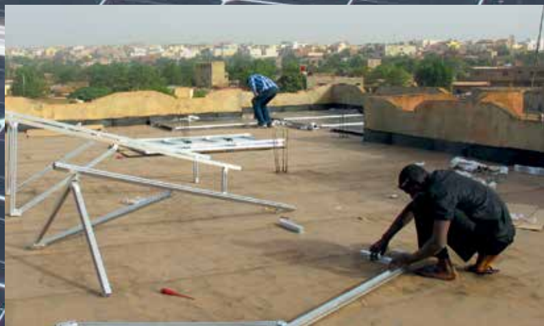
Anlieferung und Aufbau der Solaranlage für das Archivgebäude in Bamako.
